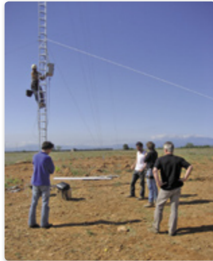
Aufbau eines Windmessmastes in den Pyrénées-Orientales
